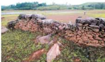
Seca praticamente acabou com a barragem Lagoa das Codornas, que pertence ao Sistema Rio das Velhas, às margens da BR-356, na Grande BH, e desvendou um muro de pedra de fazendas que foram inundadas
