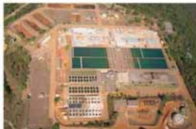
Copasa trabalha com possibilidade de manuseio caso não aguar
