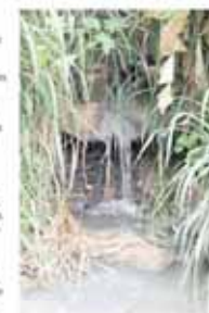
Esgoto cai livremente no curso do Rio Taquaraçu e compromete a qualidade da água que pode abastecer a Grande BH
